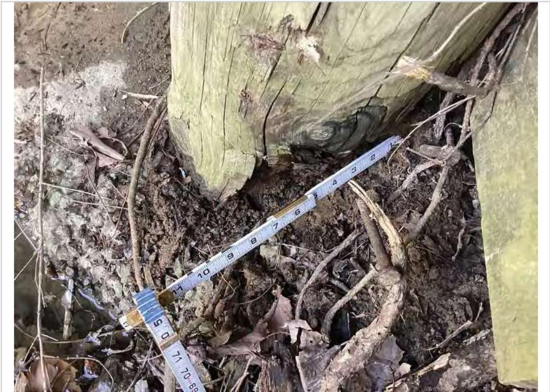
Bent #1 pile B decay
